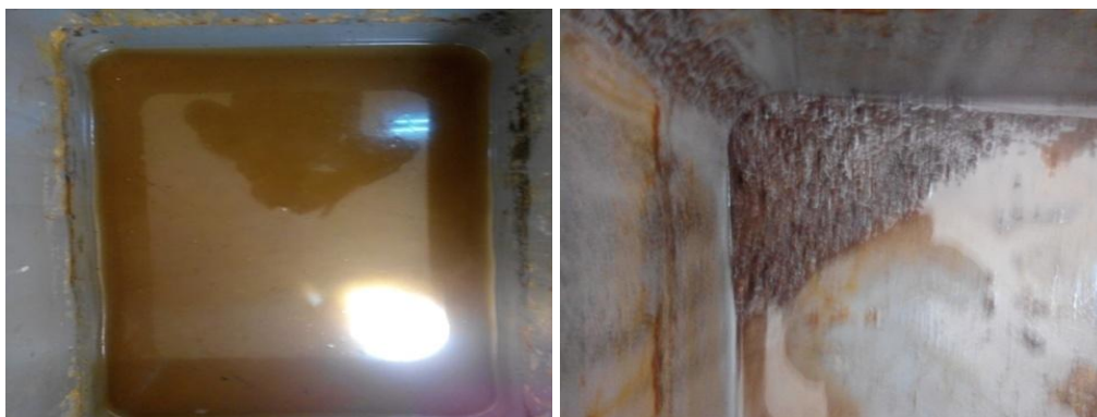
Figure 7. Solution d'acide chlorhydrique Hcl et débris de béton
