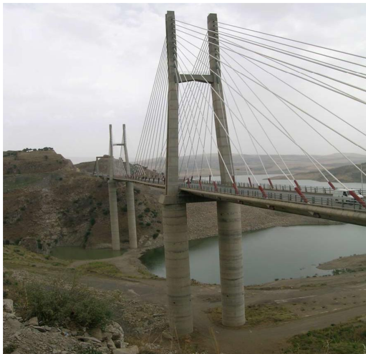
Figure. 1 Vue d'ensemble du pont à haubans.
