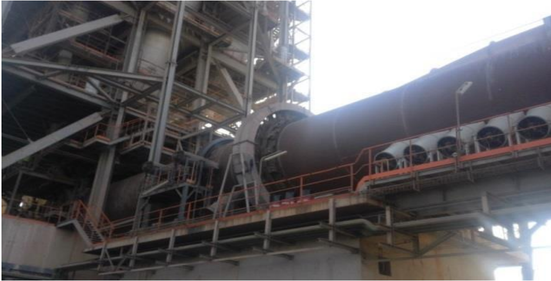
Fig. 1-1 : Le four rotatif des cimenteries
