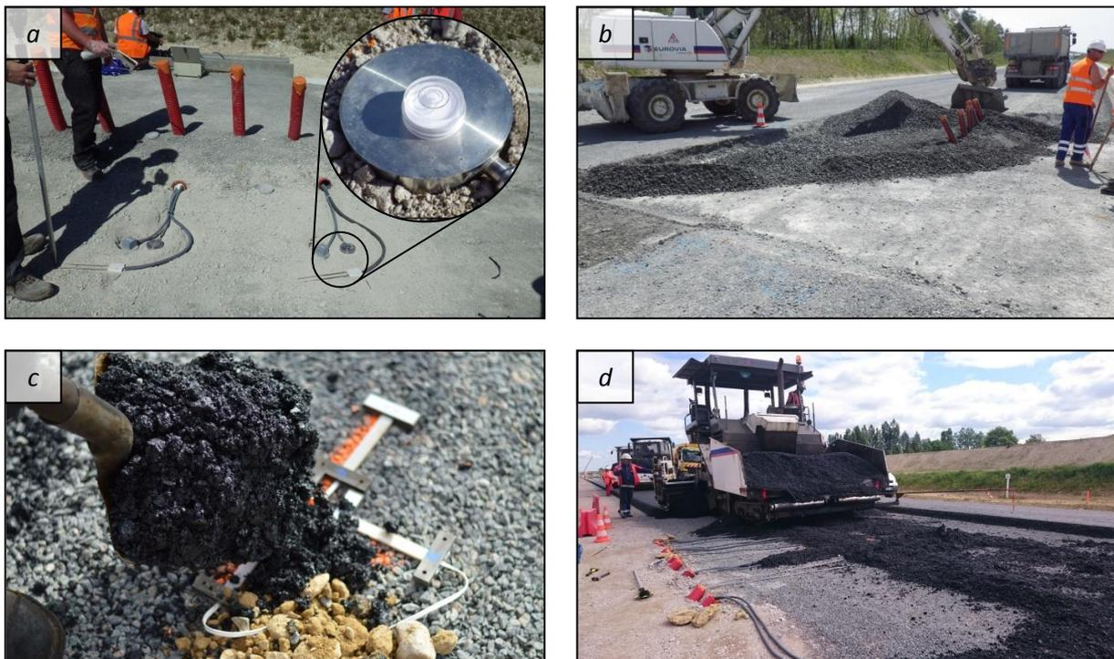
Figure 4. Photographies illustrant les travaux d'instrumentation de l'infrastructure de la voie.
